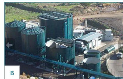
Instalacja ArrowBio: a) zbiornik hydroseparacji b) zbiorniki fermentacji metanowej
